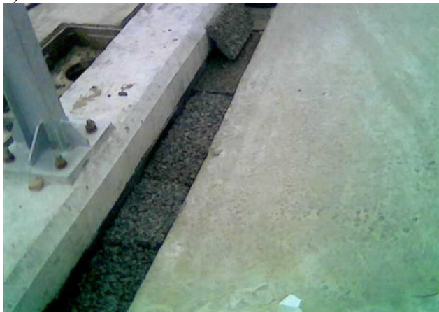
Схема 2 Образование дренажного канала:
