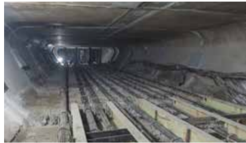
Восстановление пучков нижней плиты коробчатого сечения пролетного строения моста
