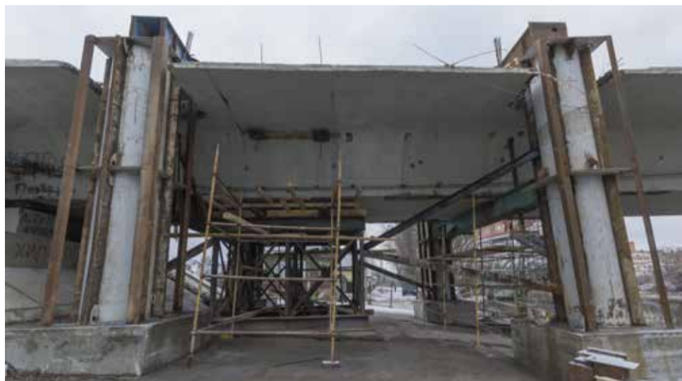
Пролетное строение моста после подъёмки
