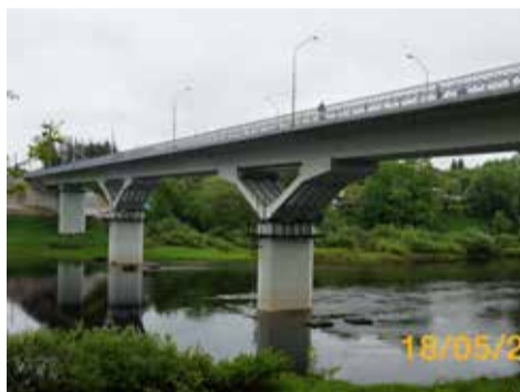
Общий вид моста
