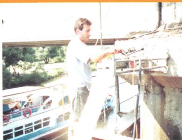
Рис. 6 Бурение отверстий в ригеле.
