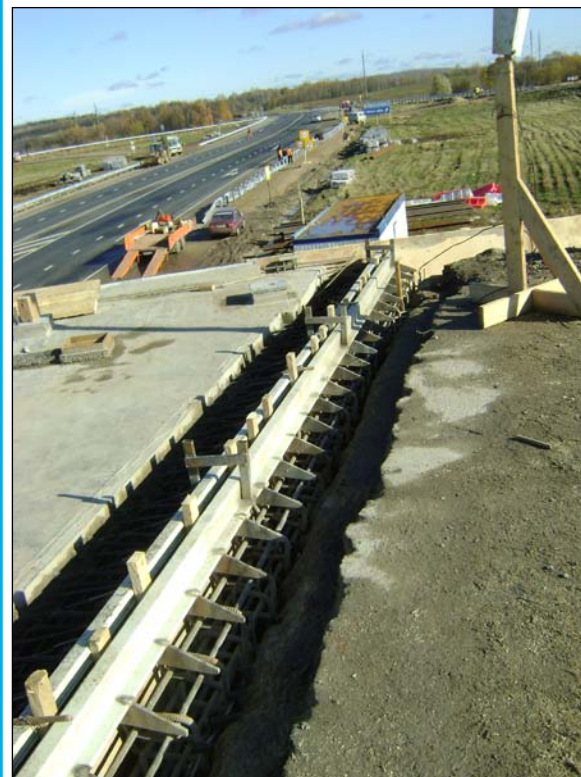
Установка конструкции деформационного шва СК-80, Переславль-Залесский.
