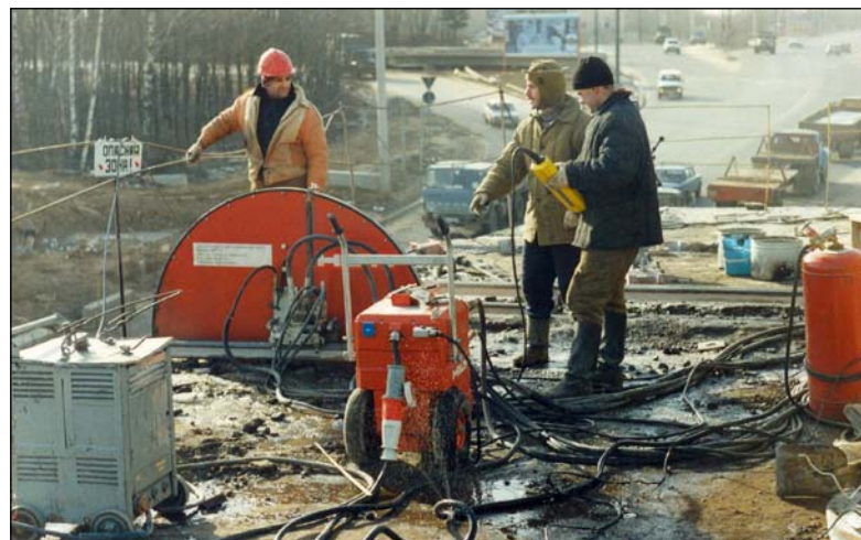
Разрезка алмазным инструментом, Волоколамская развязка.
